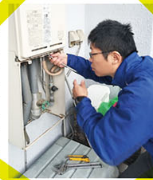
給湯器修理中!
