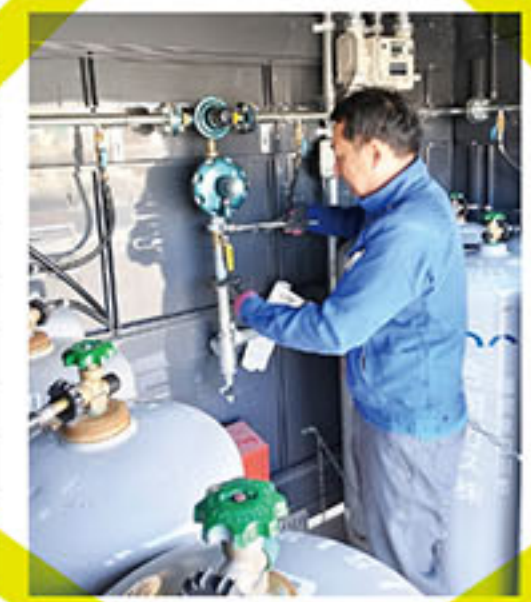
ガス設備取替中!
