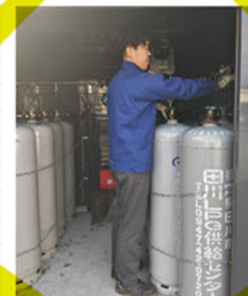
ガスボンベ設置中!
