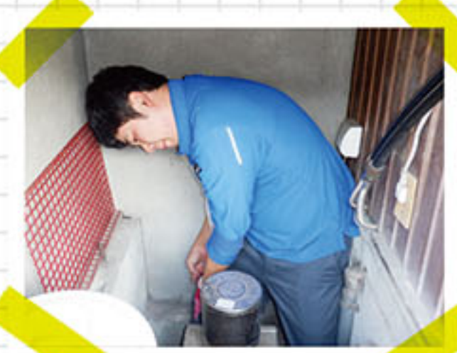
風呂釜点検中!
