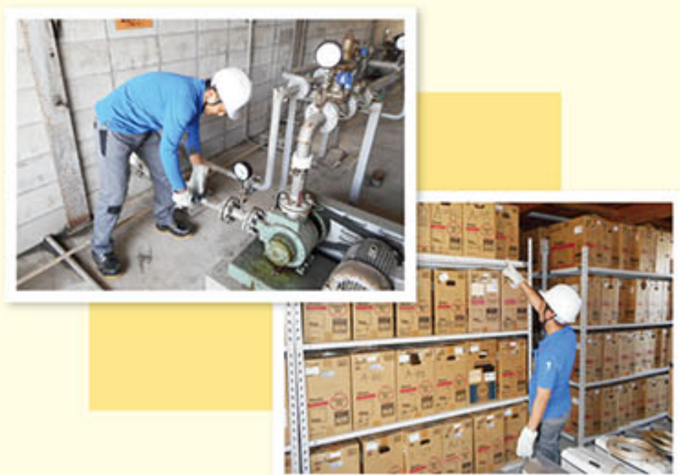
4 社内設備の安全点検
